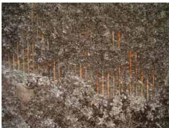
図 1-20. スクリーンの状況（上側は以前に棒で掻き落とした部分。上側には新たに付着した比較的小型の個体が見られる。）
