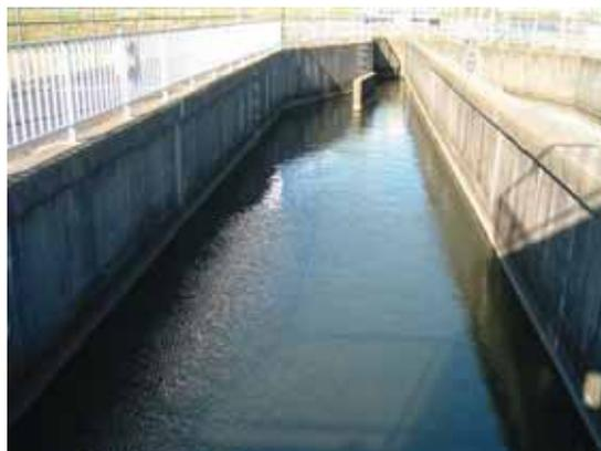
図 1-17. 満水状態の沈砂池（並行するライン）
