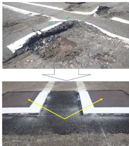
事業イメージ②(鉄板敷設)
