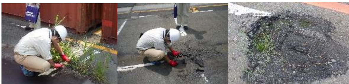
コンテナヤードでの確認
