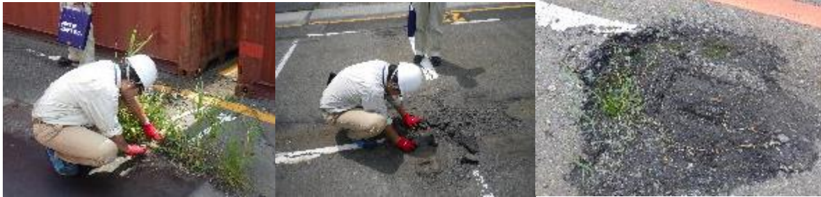
コンテナヤードでの確認
