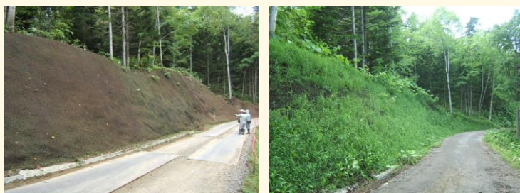
〈地域性種苗による法面緑化 施工前(左)と施工後(右)〉
