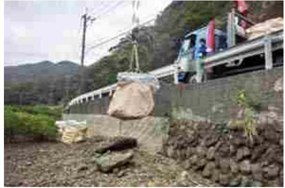
海ごみの回収作業
