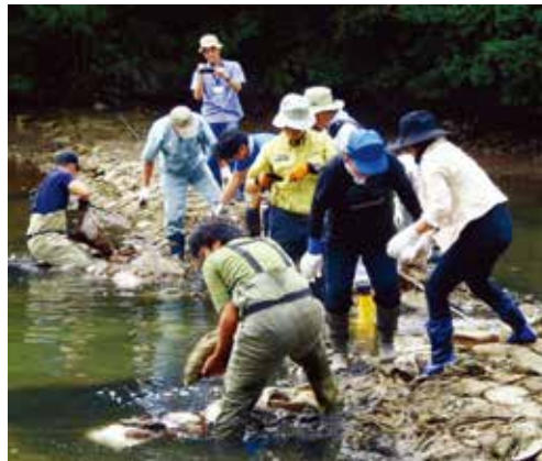
土のうを手作業で撤去
