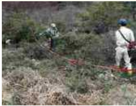
湿地再生作業
