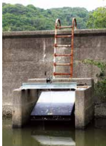
堤防に設置された水門
