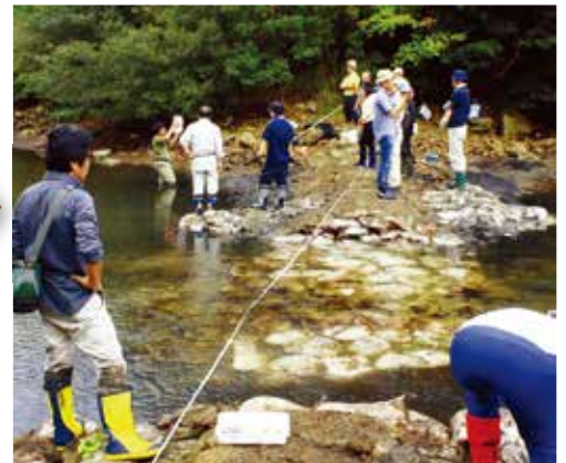
撤去後の堤防
