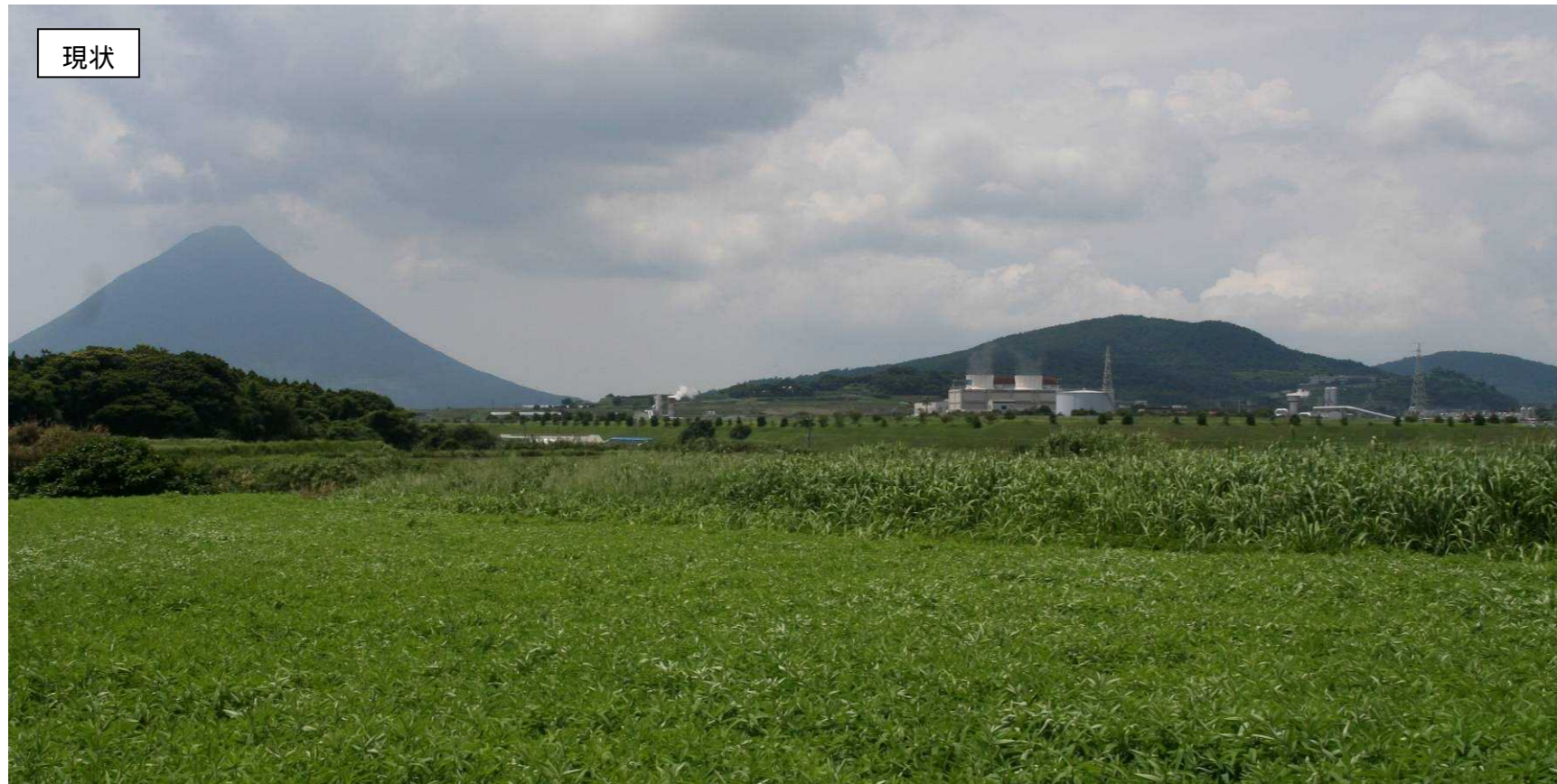
山川発電所 (竹山神社付近より)
