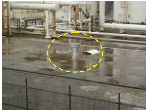
廃坑後の状況
