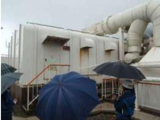
タービン建屋（高さ 3.5m）
