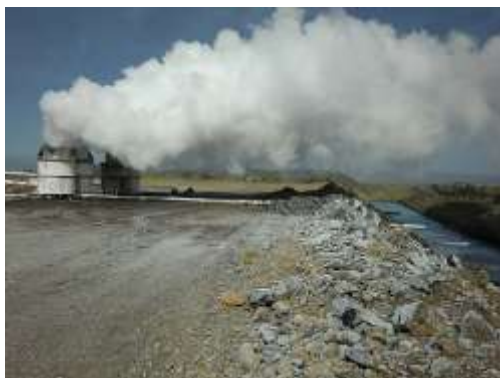
写真：試掘井から放出される蒸気
