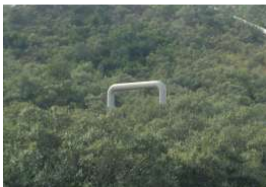
写真：蒸気パイプのループ構造（キリン通行用）
