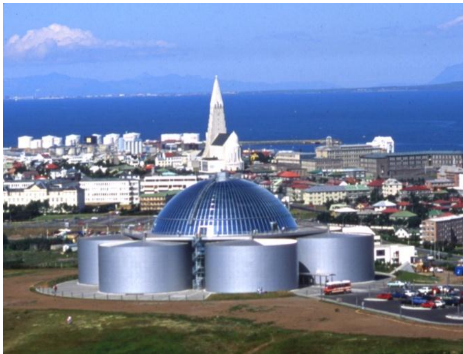
図5 市街地の高台に設置されている熱水タンク
