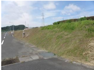
法面は夏季の草刈の時期にあたり、刈り込み作業中であった。
