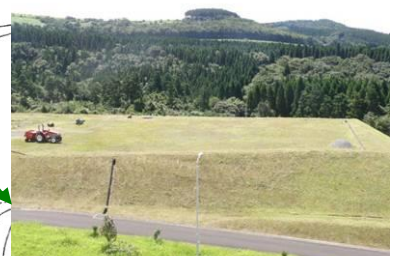
発電所南東方向の施設予定地。夏季の草刈作業中。
