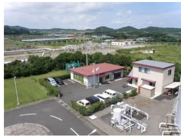
発電所の北東方向。周辺は畑地で遠方の山地の森林が見える。
