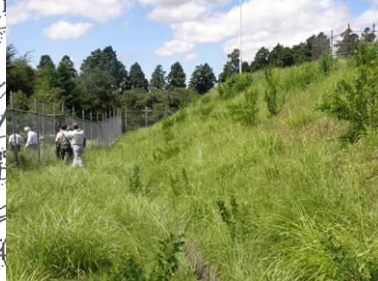
調整池周辺の法面。マルバハギが生育するが、導入されたか、あるいは法面吹付の際に非意図的に入ったものとみられる。
