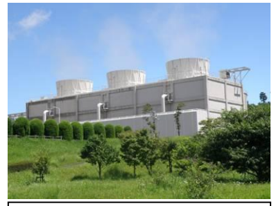
冷却塔周辺も本館と同様に修景植栽されている。
