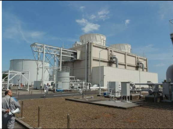
冷却塔（高さ約 18.7m）
