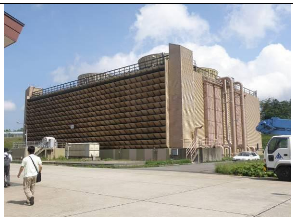
冷却塔（高さ約 21m）
