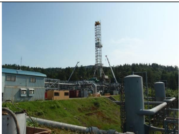
補充井掘削基地（樽）
