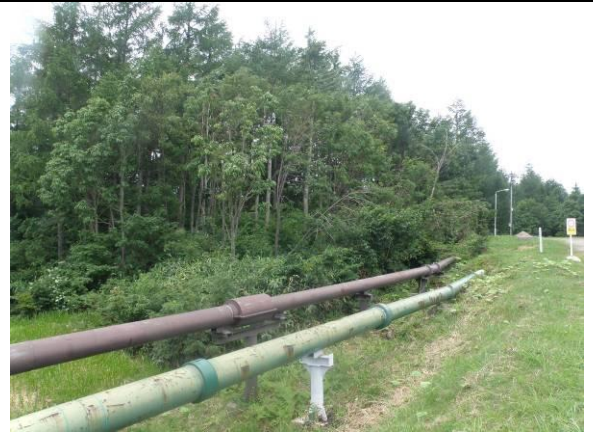
配管（設置年代により色が異なる）
