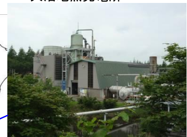
大沼地熱発電所
