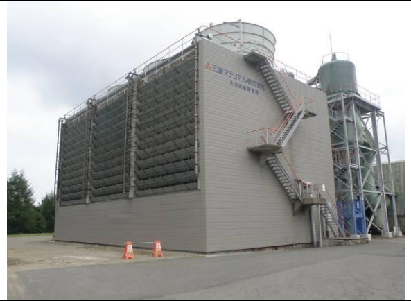
冷却塔（高さ約16m）
