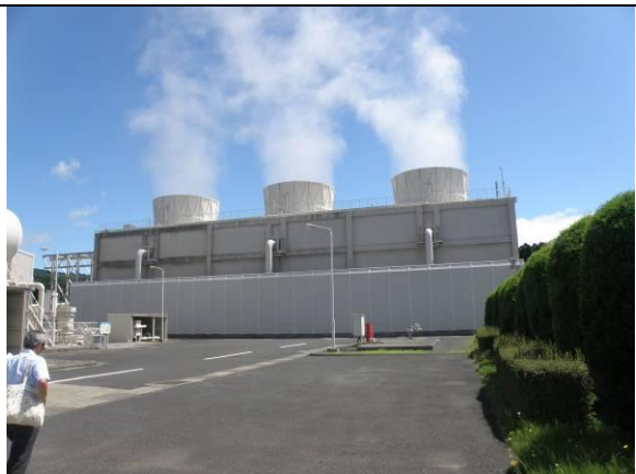
冷却塔（高さ約 18.7m）
