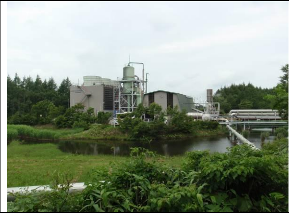
発電所本館および冷却塔
