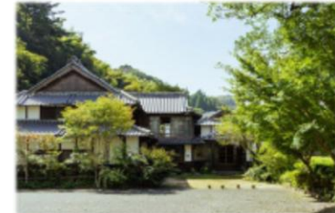
受入拠点の改修
