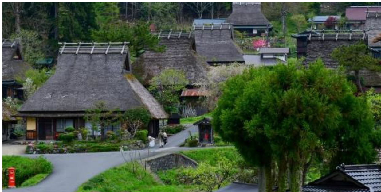
重要伝統的建造物群保存地区「美山かやぶきの里」
