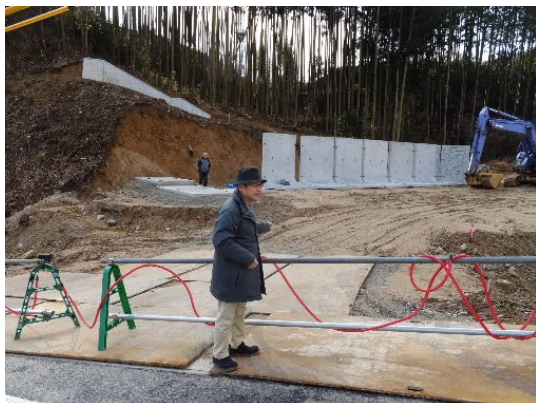
環境教育棟建設予定地
