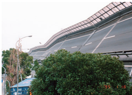
阪神・淡路大震災での深江本町阪神高速倒壊 (写真提供：神戸市)
