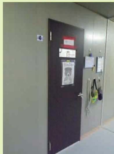
ドアに飼育舎内確認用の小窓を設置
