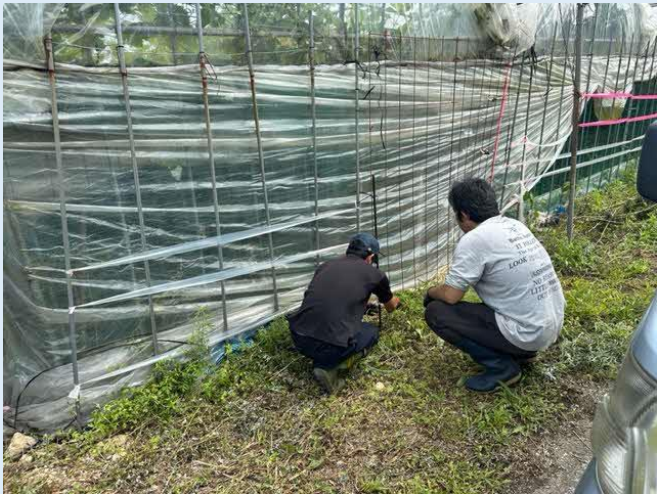
貸出電気柵の設置の様子
