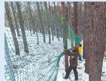
誘導柵設置状況
