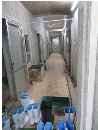
写真 24 検疫隔離棟の廊下と左右の飼育室
