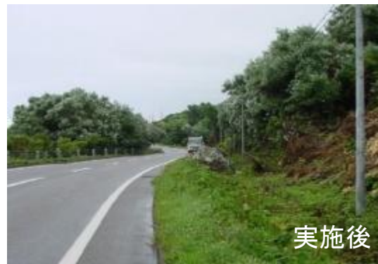
緩衝帯の整備
