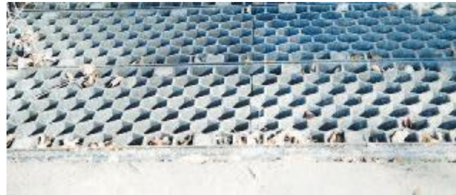
道路に設置されたグレーチング
