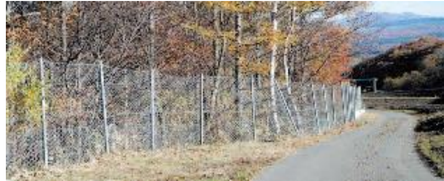
森林との境界部に設置された金網柵
