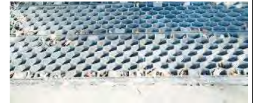
道路に設置されたグレーチング
