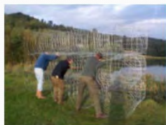
シーブ・ワイヤーで作った円筒の組み立て 抽水植物が植えられたいかだの構造物
