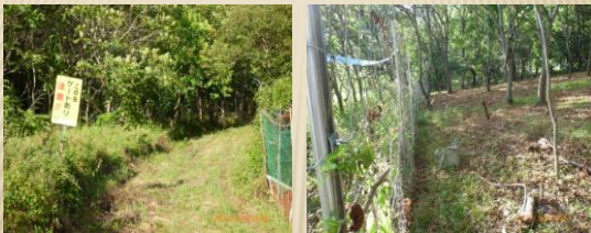
里側 山側 中山地区（和泉地区） 獣害侵入防止柵（里側から山側を見る）
