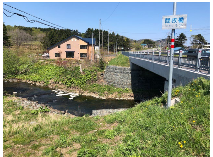
図2 問牧橋上流側の淵と左岸の住宅
