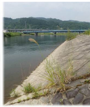
図 -3-37. コンクリート護岸
