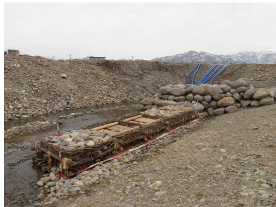
図 -3-40. 粗朶沈床図
