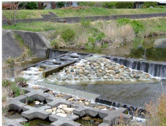
図 -3-38. 山口県榎野川に設置された「水辺の小わざ魚道（側面設置型）」 浜野龍夫氏撮影
