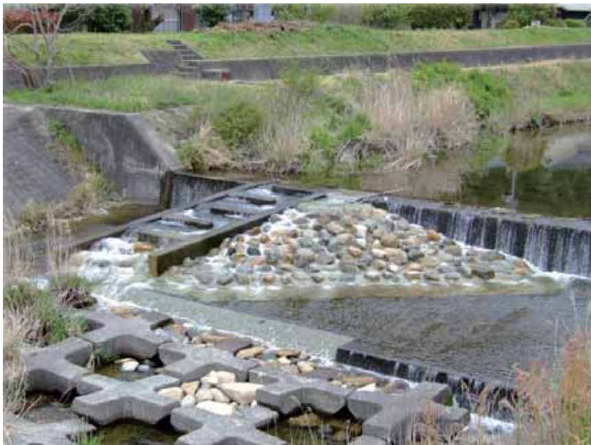
図Ⅱ2-3(3)-21. 山口県樫野川に設置された「水辺の小わざ魚道（側面設置型）」 浜野龍夫氏撮影
