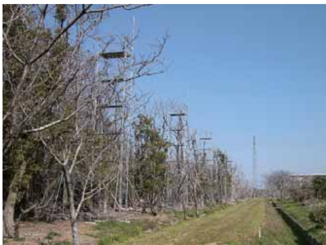
図Ⅱ2-3(3)-34. 鉄塔間のロープ張りによるカワウ飛来防止
