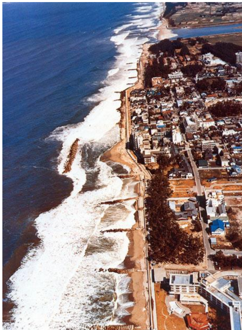
日本における海岸浸食 離岸堤1号の建設(皆生海岸)
