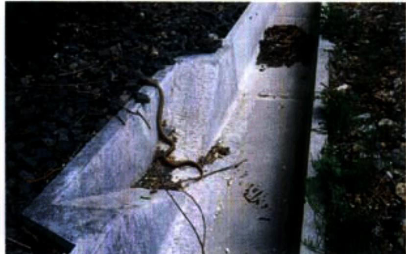
側溝には傾斜面が設けられ、ヘビやカエルなどの小動物が落ちても這い上げれるようにしている。
