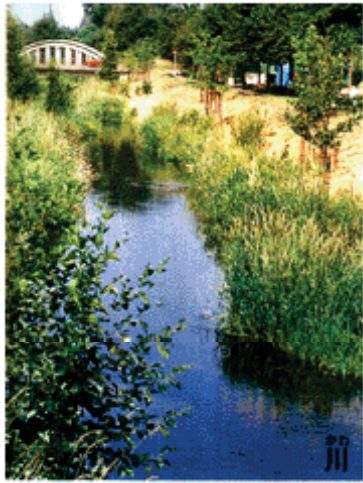
◀コンクリートで直線にした川をもとのようにもどしたよ。
