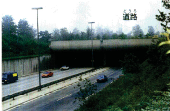
▲トンネルをつかって道路を地下にもくらす。トンネルの上は生きものが行き来できる。
