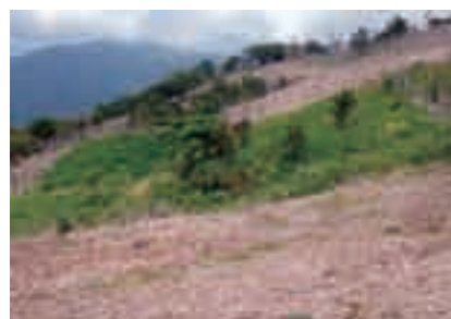
植生防護柵の設置（高知県：三嶺の森） 三嶺の森をまもるみんなの会提供
