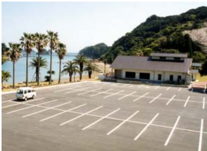
アスファルト舗装
