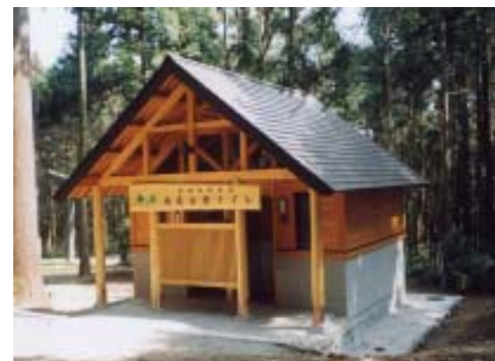
公衆トイレ整備後
