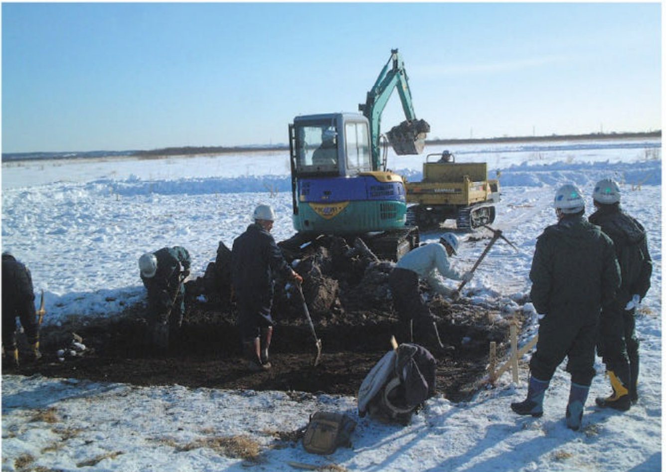
広里地域:人力と小型重機を用い、環境に配慮して行った表土はぎとり作業
