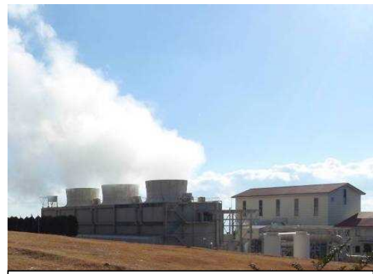
冷却塔から立ち上る水蒸気
