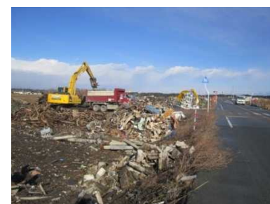
浪江町における津波がれきの撤去状況(平成26年12月)
