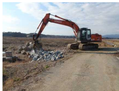
南相馬市における津波がれきの撤去状況(平成26年12月)
