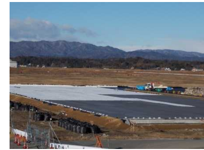
双葉町中野地区における仮置場の整備状況(平成26年12月)
