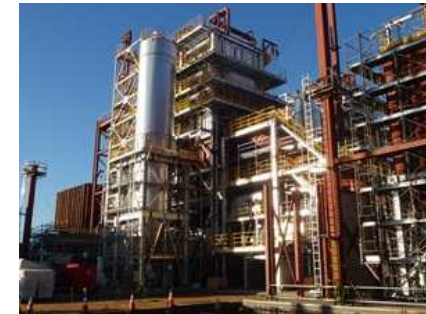
富岡町における仮設焼却施設の建設状況(平成26年12月)
