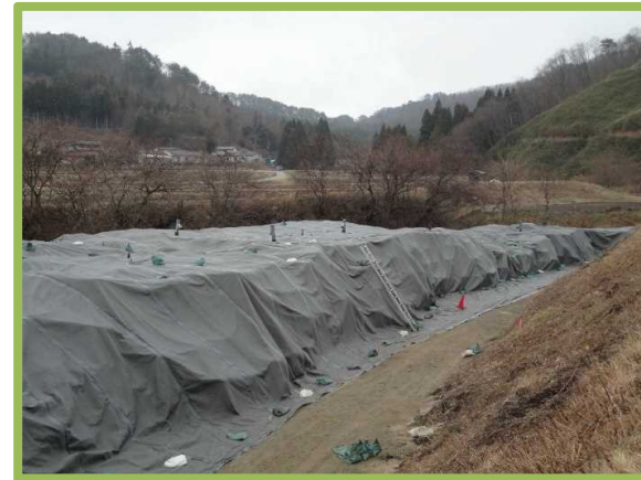
雨水浸入防止の措置の例
