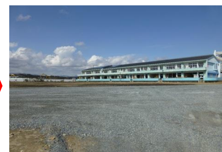
撤去後(平成27年3月)
