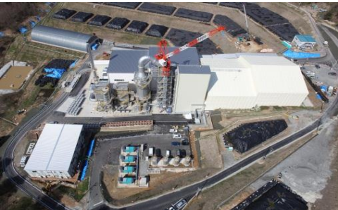
葛尾村の仮設焼却施設 (平成27年4月)
