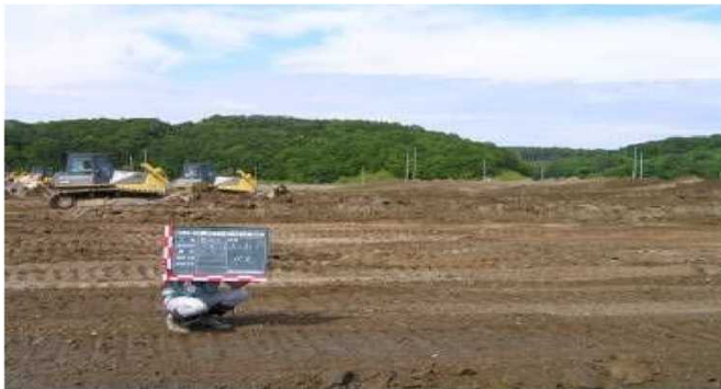
区画整理(表土はぎ取り) (事業主体:県)
