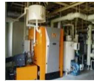
熱供給施設等での利用
