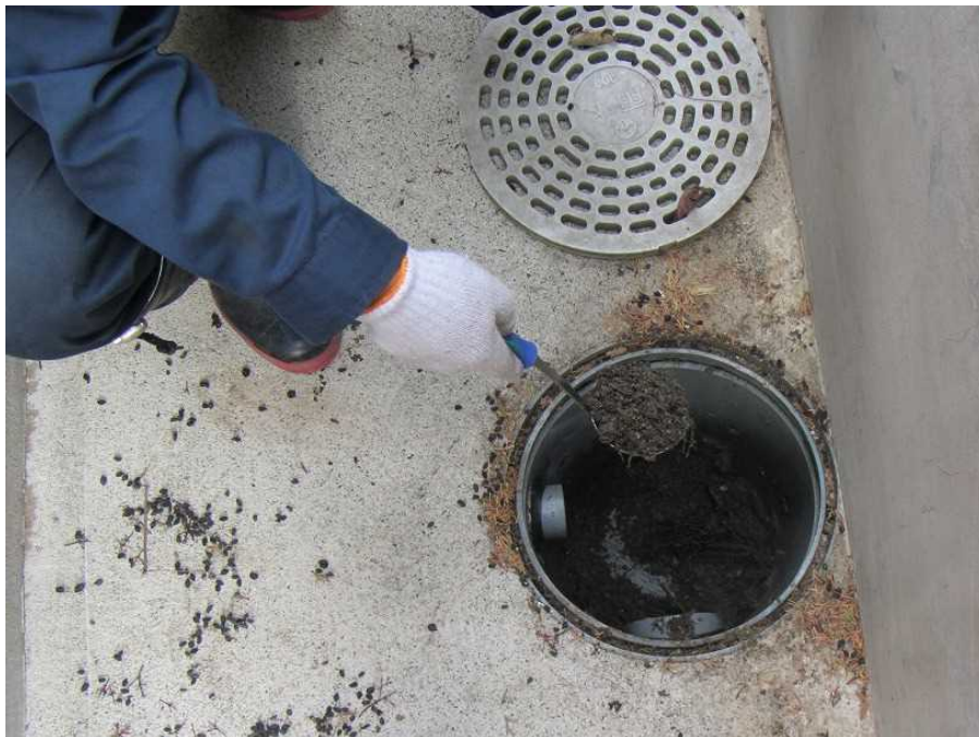
図 2-24 雨水枡の除染の例（堆積物の除去）
