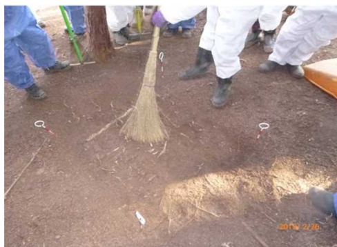
図 2-67 落葉等の堆積有機物除去の例
