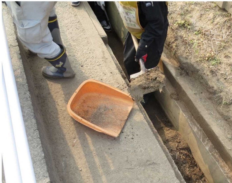
図2-42 側溝の除染の例（堆積物の除去）
