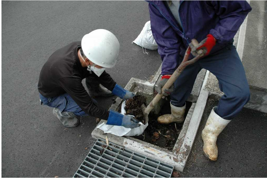
図 2-23 側溝の除染の例（堆積物の除去）
