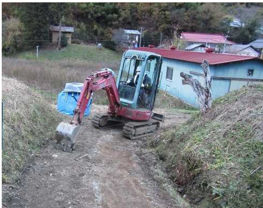
図 2-39 未舗装道路の除染の例（削り取り）
