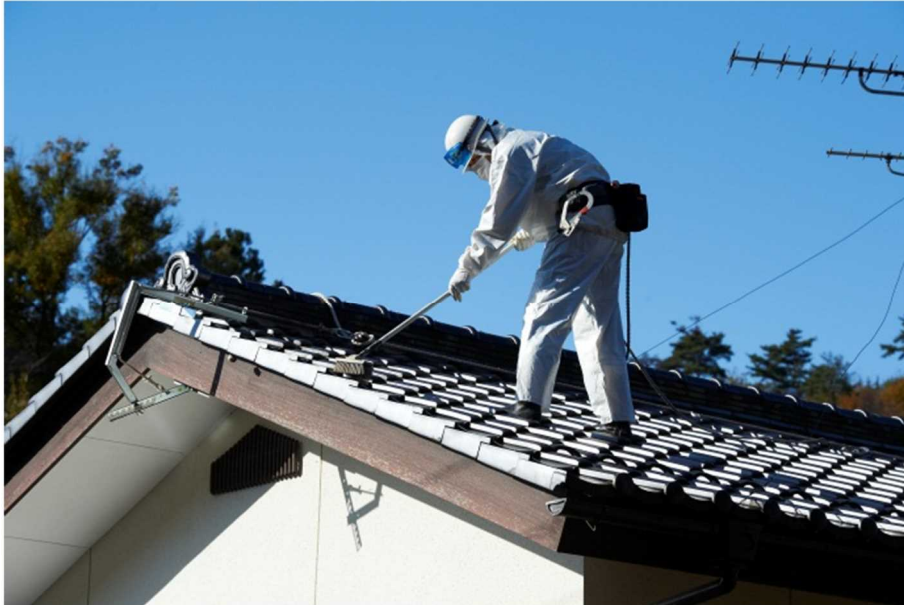
図 2-10 屋根の瓦の除染の例（洗浄）
