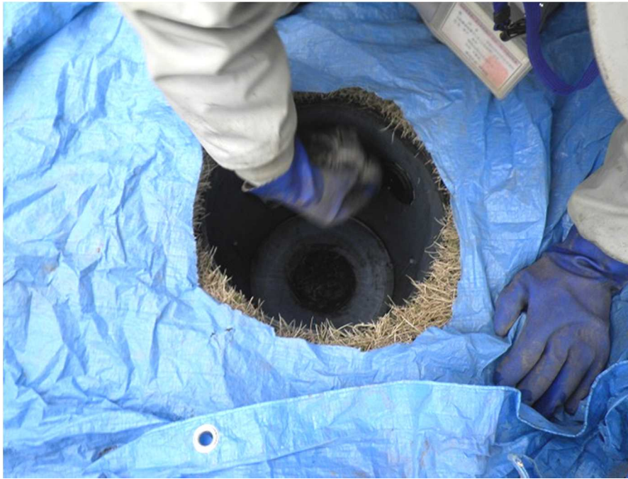
図2-27 雨水枡の除染の例（スポンジ洗浄）
