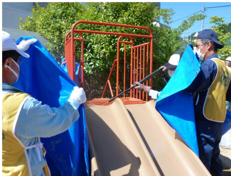
図 2-17 遊具の除染の例（高圧水洗浄）
