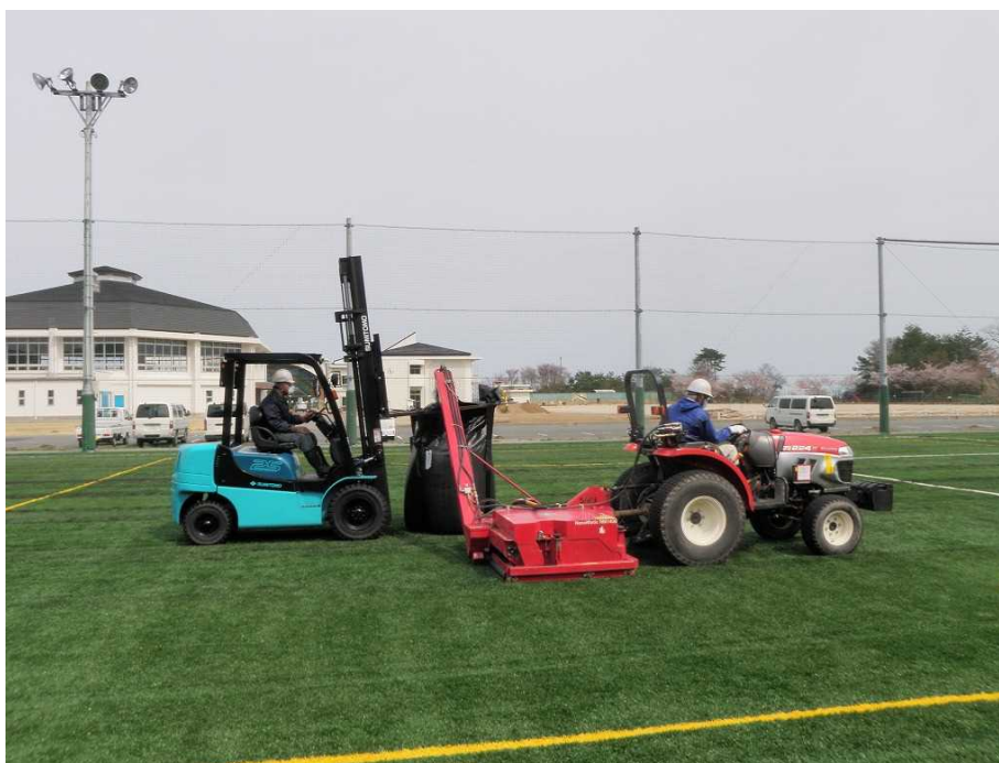
図 2-51 人工芝の充填材の除去の例
