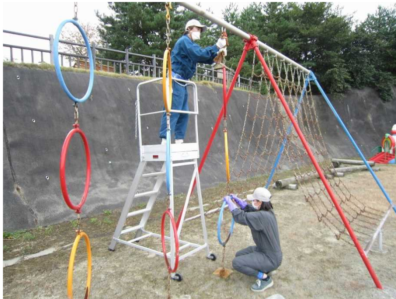
図 2-16 遊具の除染の例（拭き取り）
