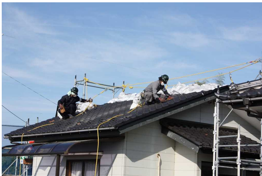
図2-9 屋根の瓦の除染の例（拭き取り）
