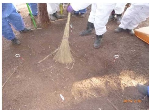
図 2-67 落葉等の堆積有機物除去の例
