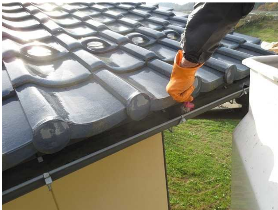
図 2-13 雨樋の除染の例（ブラシ洗浄）
