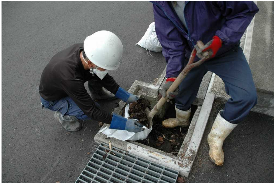
図 2-23 側溝の除染の例（堆積物の除去）
