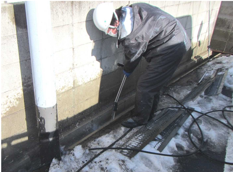
図 2-26 側溝の除染の例（高圧水洗浄）
