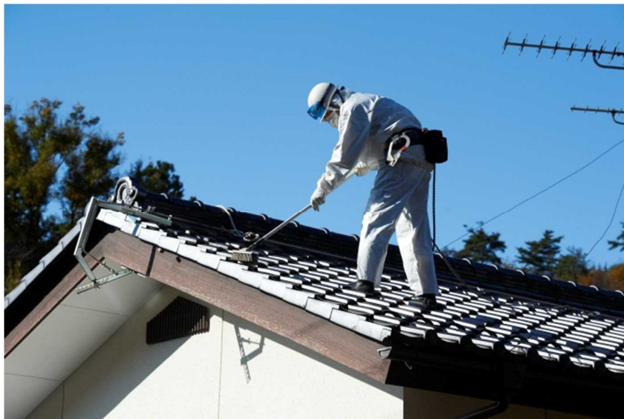
図 2-10 屋根の瓦の除染の例（洗浄）
