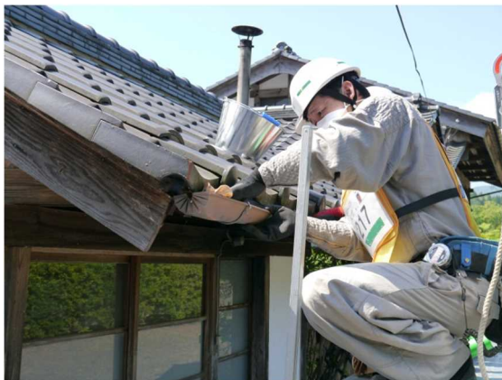
図 2-12 雨樋の除染の例（拭き取り）
