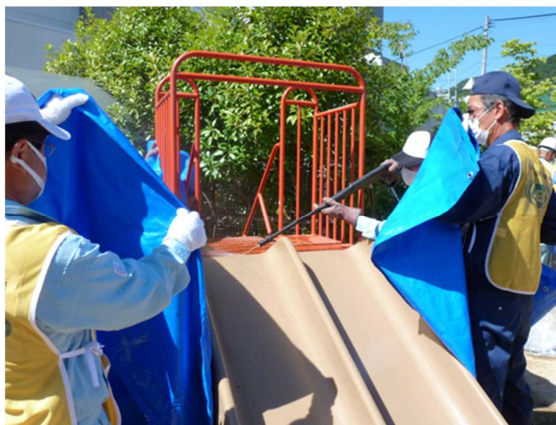
図 2-17 遊具の除染の例（高圧水洗浄）
