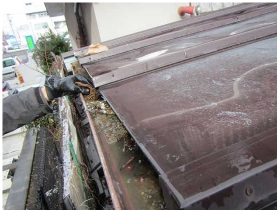
図 2-12 雨樋の除染の例（拭き取り）
