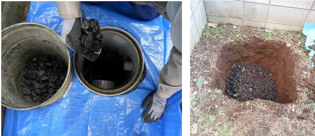
図 2-25 雨水枡の除染の例(堆積物の除去と同一敷地内における雨水枡堆積物の天地返し)
