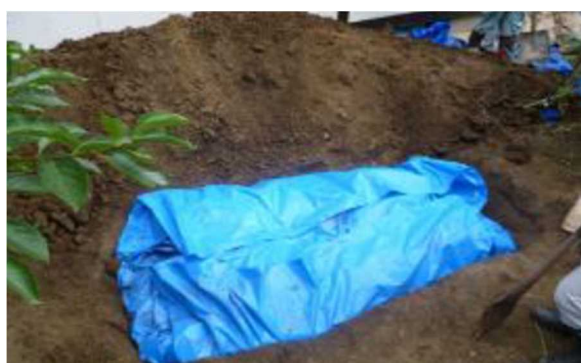
図4-6 現場保管（地下保管）例
