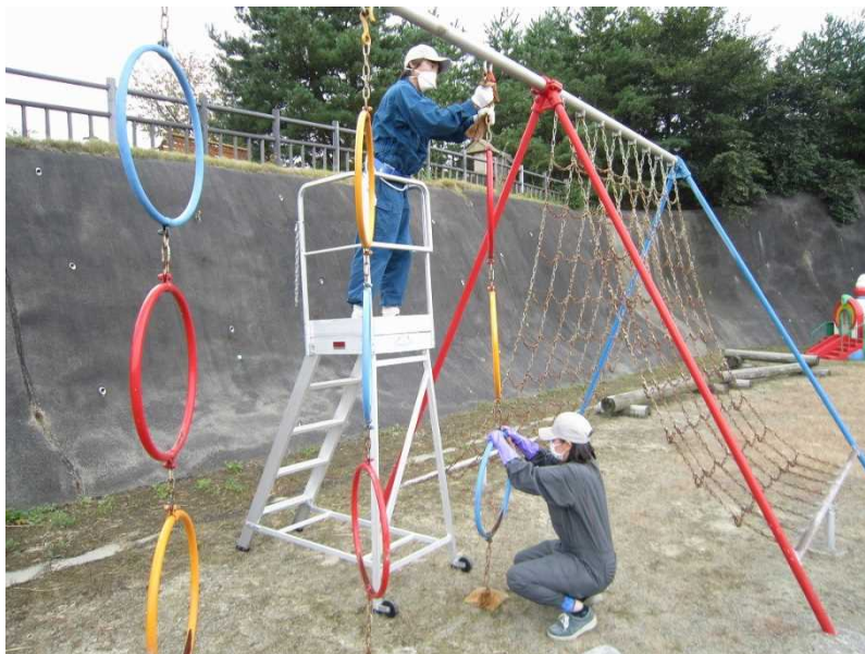
図 2-16 遊具の除染の例（拭き取り）
