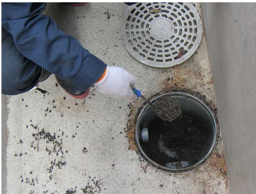
図 2-24 雨水枡の除染の例（堆積物の除去）
