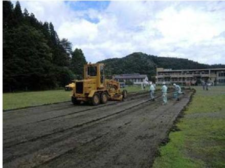
②除去した土を埋設するための空洞を掘削
