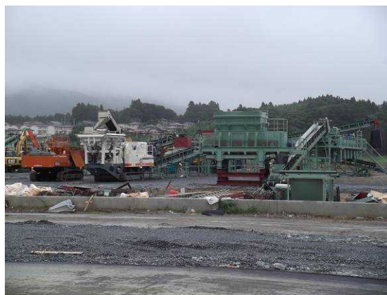
ガラス系混合物の破碎・選別ライン
