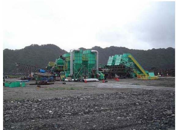
片岸地区仮置場（二次仮置場） 混合物処理ライン（工事中）
