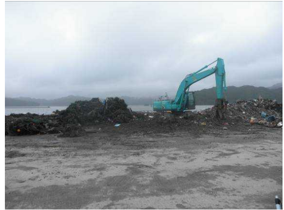
重機による漁具の裁断・選別
