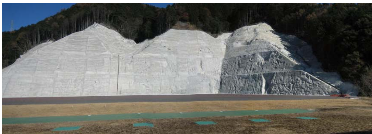
図 5 - 8 場内斜面部モルタル吹付け状況の例 2
