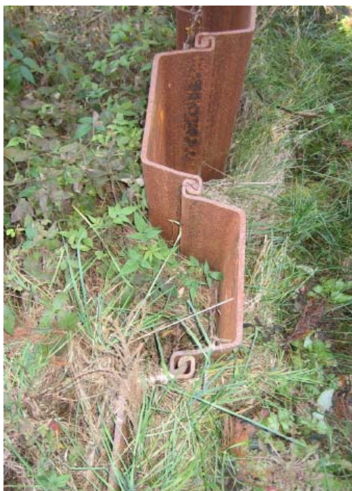
図5-28 遮水壁（鋼矢板）の設置状況の例
