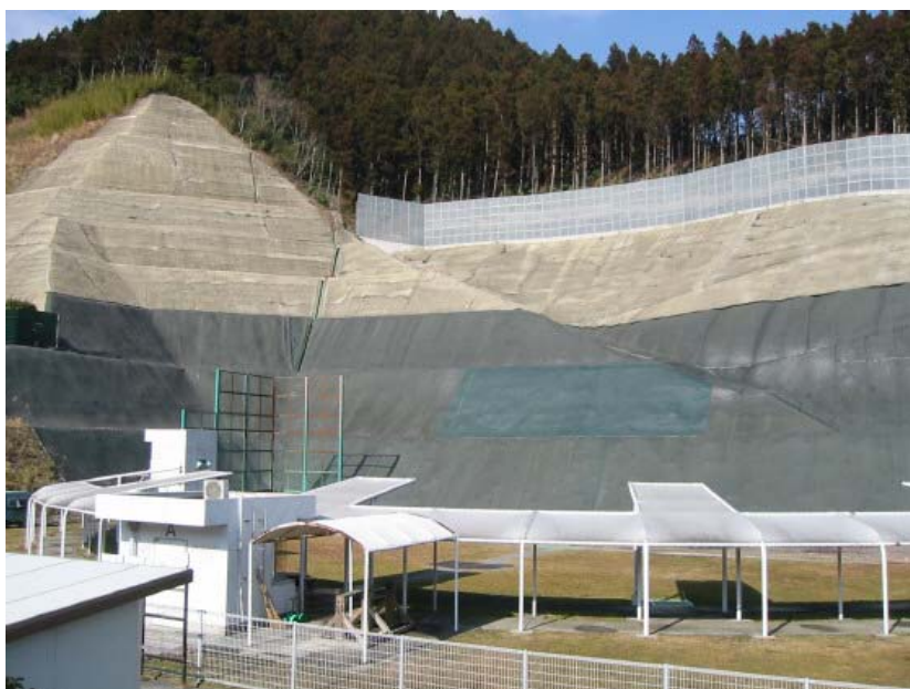
図 5 - 7 場内斜面部モルタル吹付け状況の例 1
