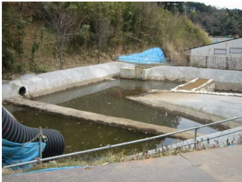
図5-19 沈殿池の例
