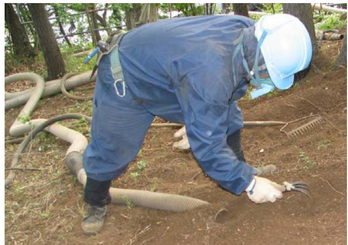
「エア圧力を利用した鉛弾混じり土壌の回収 (左上は表層土壌をほぐしている状況、右下はほぐした鉛弾混じり土壌を 吸引パイプに掻き入れている状況)
