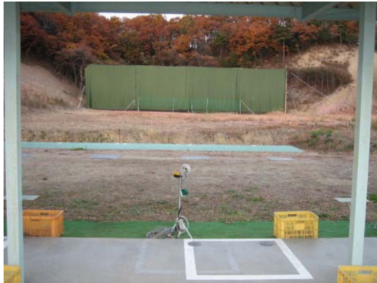
図 5 - 2 5 飛散防止ネットの設置例
