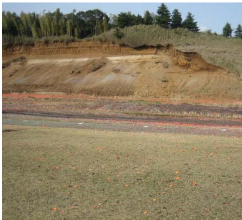
図5-3 場内の整地の例 (写真手前側を平坦に整地している)
