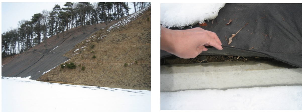
図5-9 シート敷設の例
