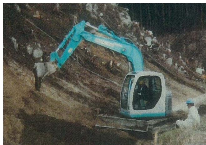
鉛弾等回収に用いる重機の例 （クローラー走行型重機の例。地表面を掘削しているところ）
