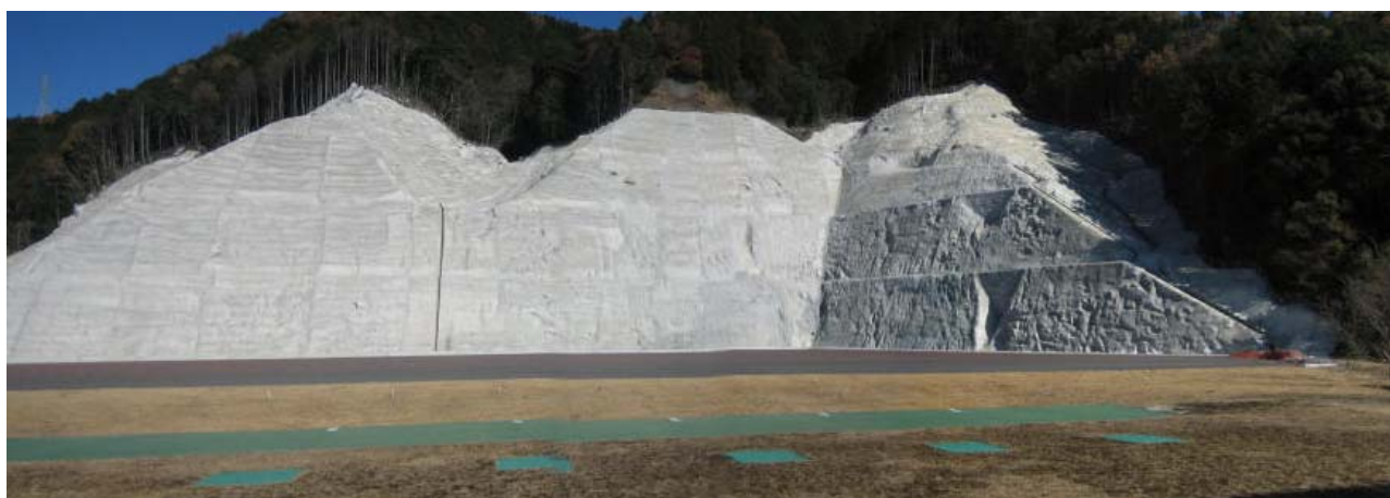
図 5 - 8 場内斜面部モルタル吹付け状況の例 2
