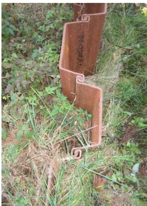
図5-28 遮水壁（鋼矢板）の設置状況の例
