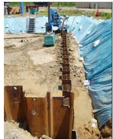
写真3-1 遮水壁(鋼矢板)の打設状況
