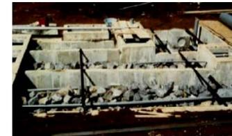
低コストで簡易な分散型排水処理施設
