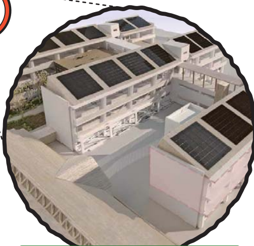
改修イメージ図。校舎3棟の屋上には、太陽光パネルや太陽熱利用設備が設置される。
