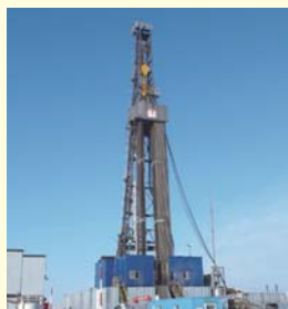
国内で初の実証試験が行われている苫小牧。写真は調査のための井戸を掘削するリグ(写真:経済産業省)
