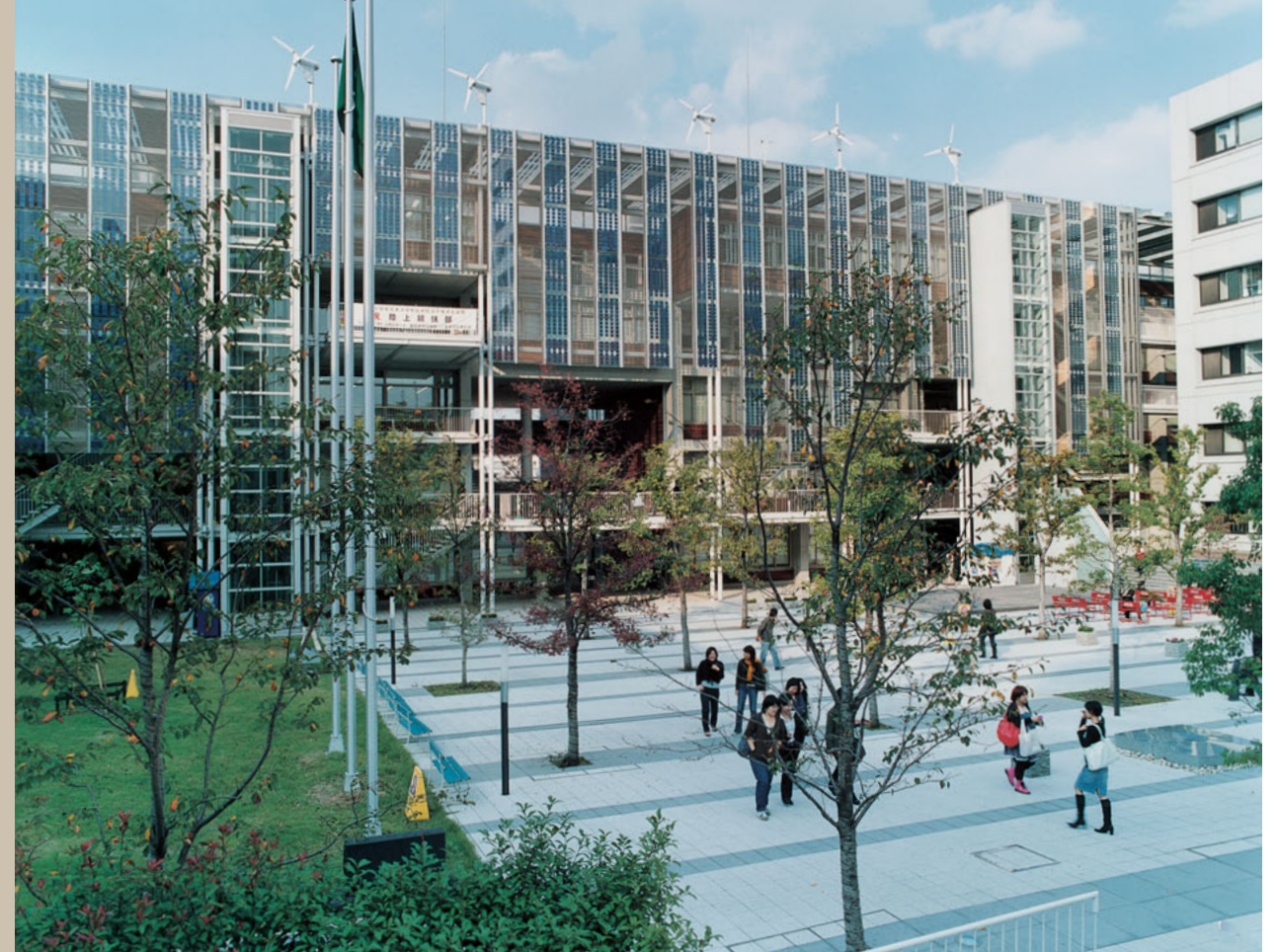
校舎の壁面が、太陽電池パネルと一体化したガラス張りとなっている、大東文化大・板橋キャンパス。
