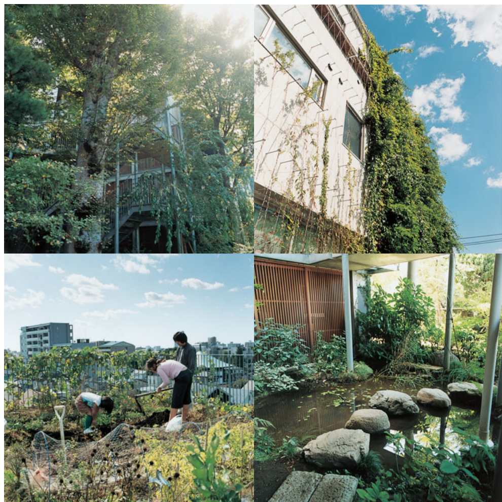
右頁／樺ハウスの正面。壁面には、植物が生い茂っている。 右上／壁面には、緑化用の杭とワイヤーが設置されており、カズラなどの蔓性の多年草を這わせている。 左上／樺ハウスの名前の由来となった、推定樹齢250年の樺の巨木。 右下／中庭にある共有のビオトープ。魚や蛙など、さまざまな生き物が棲んでいる。 左下／屋上菜園で、芋掘り中。60cmの厚さで敷いてある土は、断熱効果もある。
