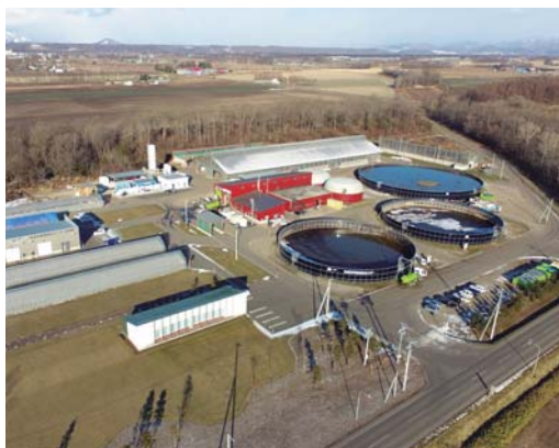
鹿追町環境保全センターにあるバイオガスプラント
