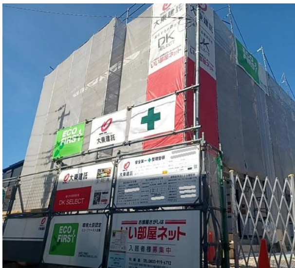
建設現場での使用 (大東建託株式会社)
