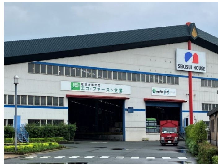
工場の壁面 (積水ハウス株式会社)
